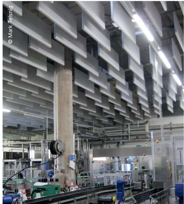
**Abb. 11:** Baffeln werden häufig in Produktionshallen mit hohen Decken verwendet.
