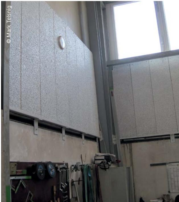
**Abb. 10:** Auch an den Wänden sollte man schallabsorbierendes Material vorsehen.
