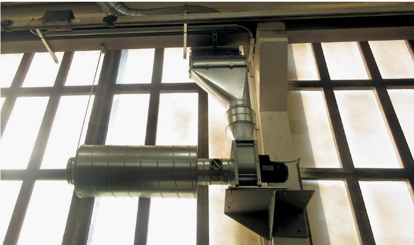
Abb. 5: Schalldämpfer bei einer Absauganlage
